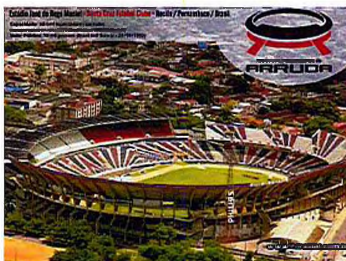
Vista aérea do Estádio após a realização do reforço estrutural nas arquibancadas em 2006.
