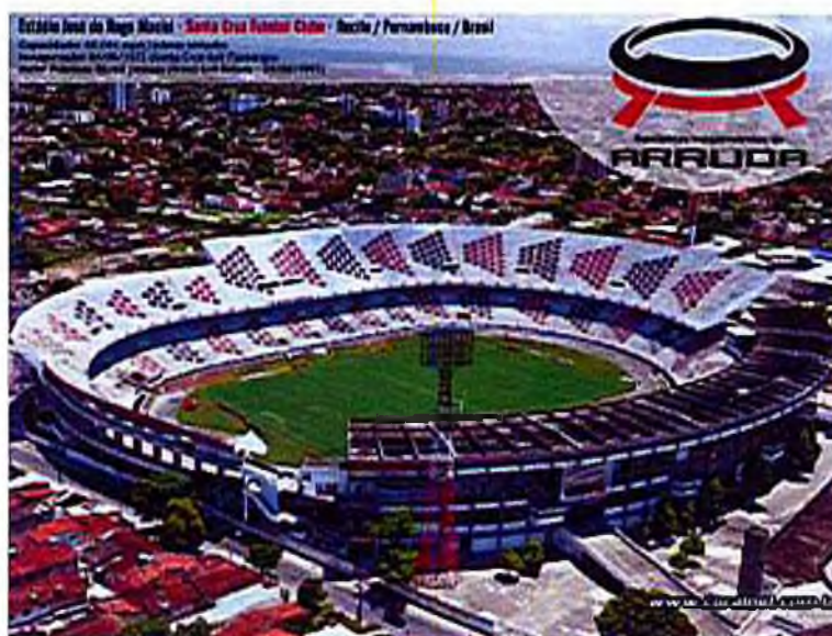
Vista área do Estádio após a realização do reforço estrutural nas arquibancadas, anel superior, substituição do gramado, drenagem e iluminação, em 2008.
