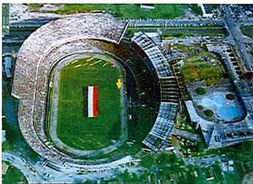
Vista aérea do Estádio José do Rego Maciel após a conclusão da obra em 1982.
